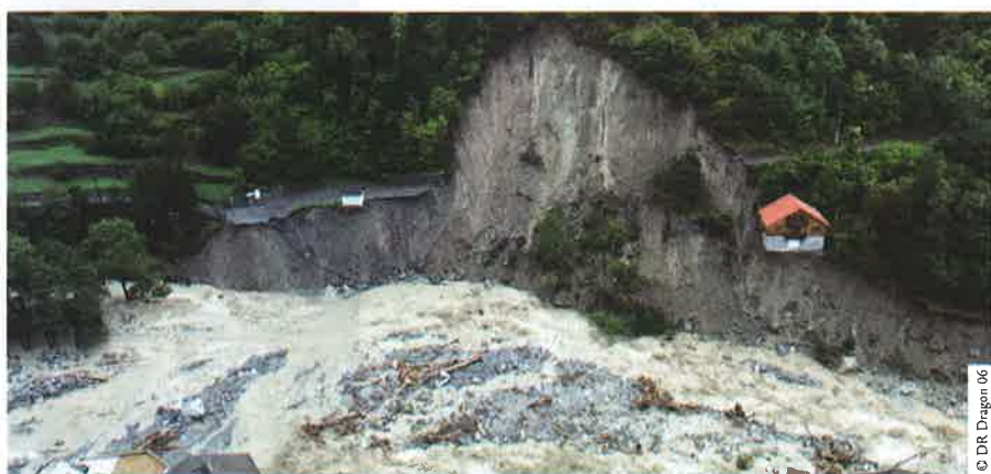
Routes emportées, maisons détruites ou endommagées, la reconstruction s'annonce longue.
